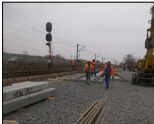
St. Crăciunel - Montare aparate de cale
