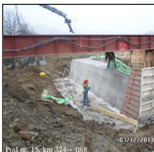
Pod nr. 15, km 324 + 088
