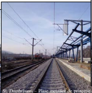
St. Dumbrăveni - Plase metalice de protecție
