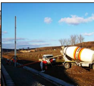
Turnare beton - fundație stâlp metalic
