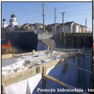
Protecție hidroizolație - tunel pietonal
