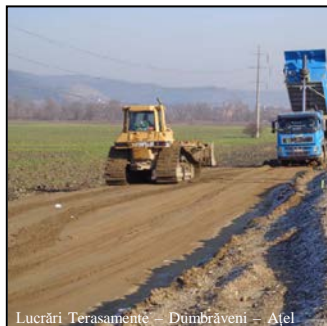
Lucrări Terasamente – Dumbrăveni – Ațel
