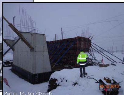
Pod nr. 04, km 303+535
