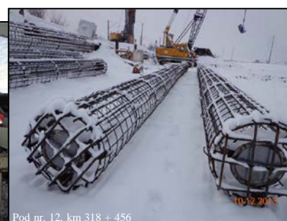
Pod nr. 12, km 318 + 456
