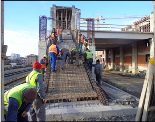
Corp B – Armare scări peron II
