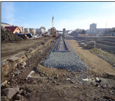
Linii CF – Suprastructură Linia 4 Cap Y
