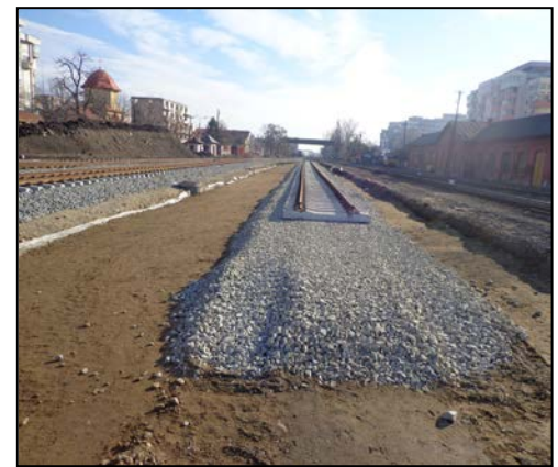
Linii CF – Suprastructură Linia I Cap X
