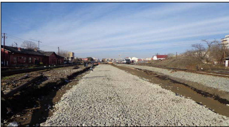
Linii CF – Strat de piatră spartă
