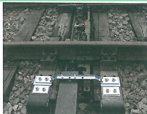
Montare inductori noi de 500Hz și 1000/2000Hz – stația Periș
