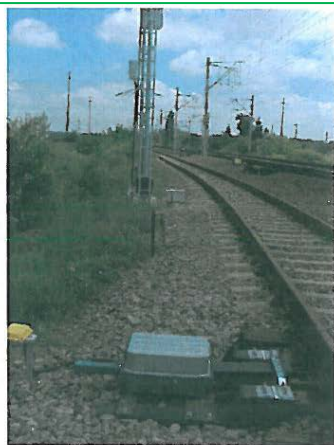
Montare inductori noi de 500Hz și 1000/2000Hz – stația Periș
